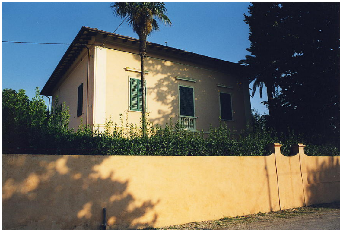
documentazione fotografica al settembre 1999
