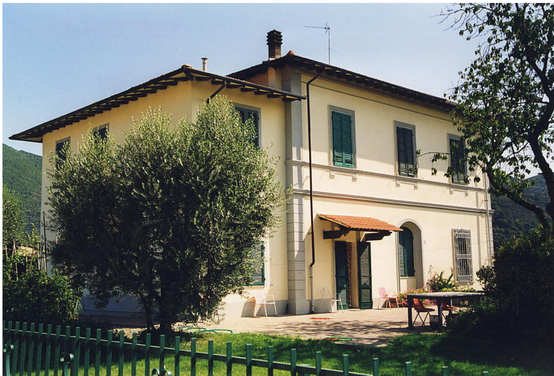
documentazione fotografica al settembre 1999
