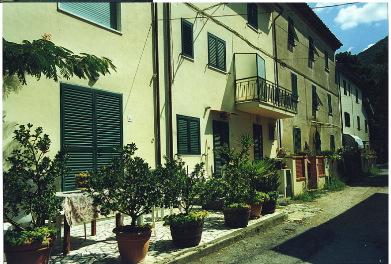
documentazione fotografica al settembre 1999
