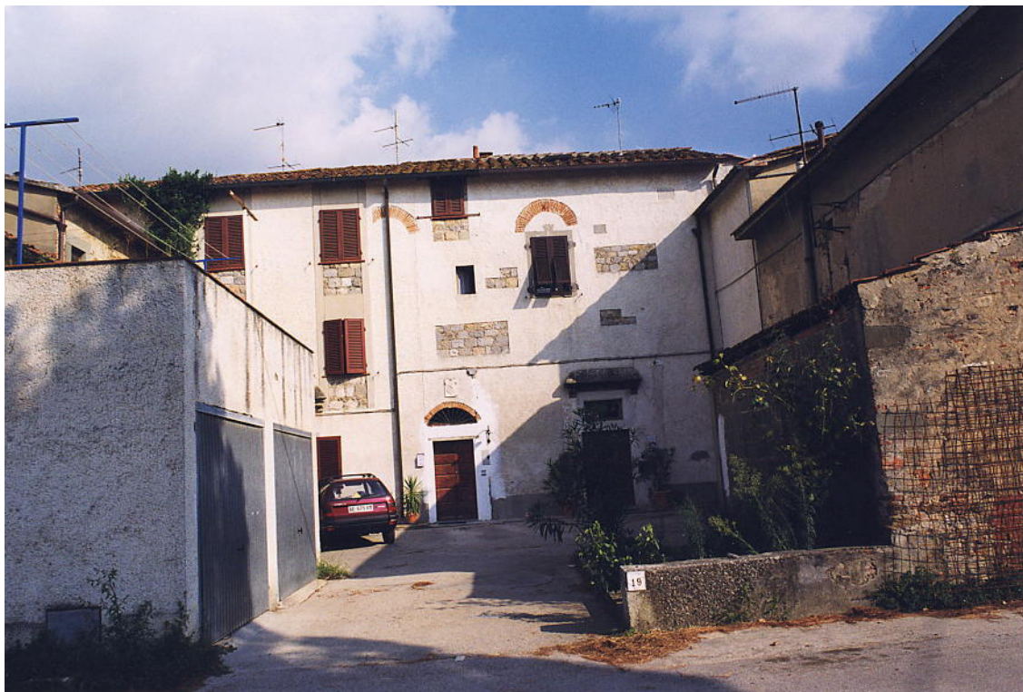
documentazione fotografica al settembre 1999
