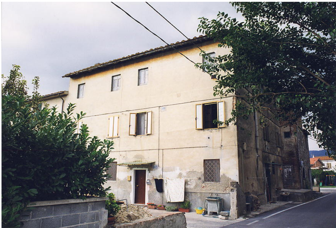
documentazione fotografica al settembre 1999
