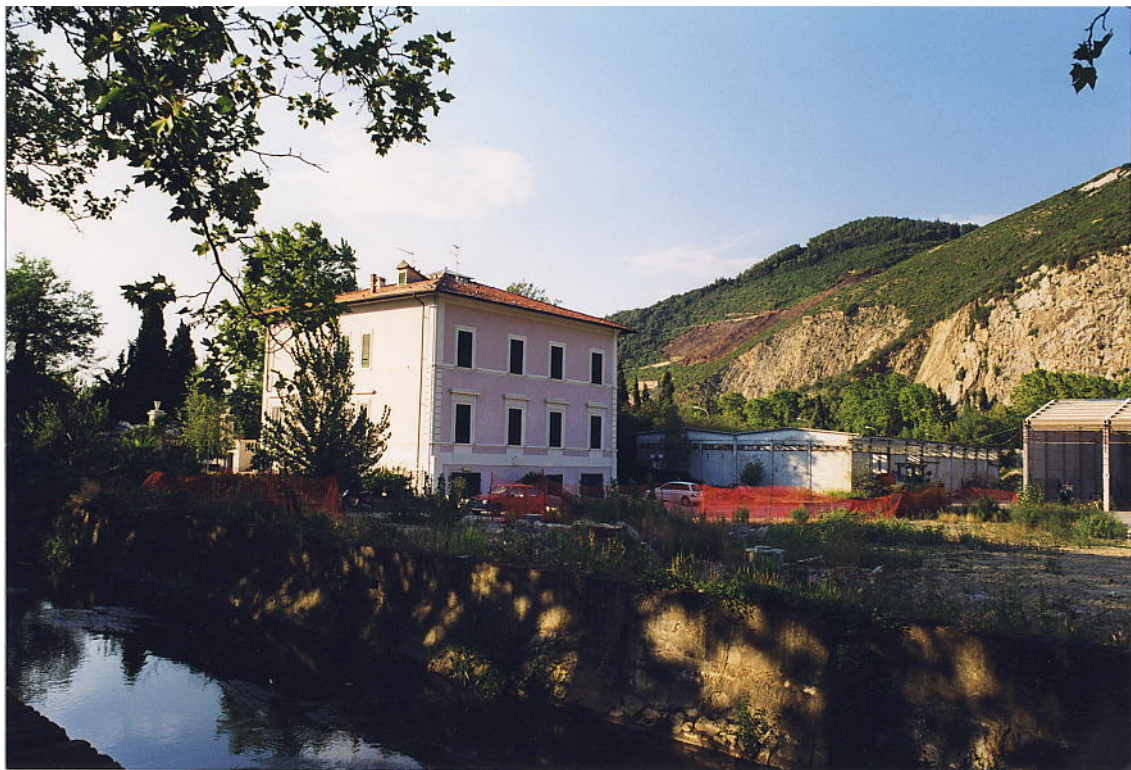
documentazione fotografica al settembre 1999
