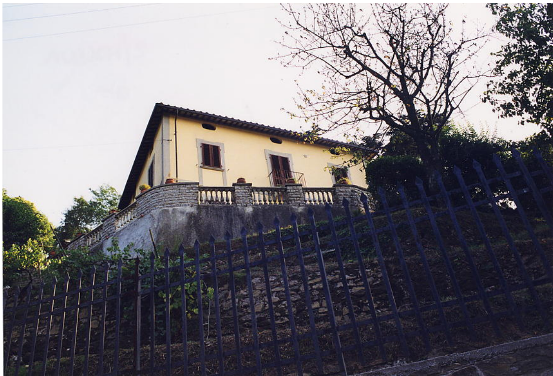
documentazione fotografica al settembre 1999
