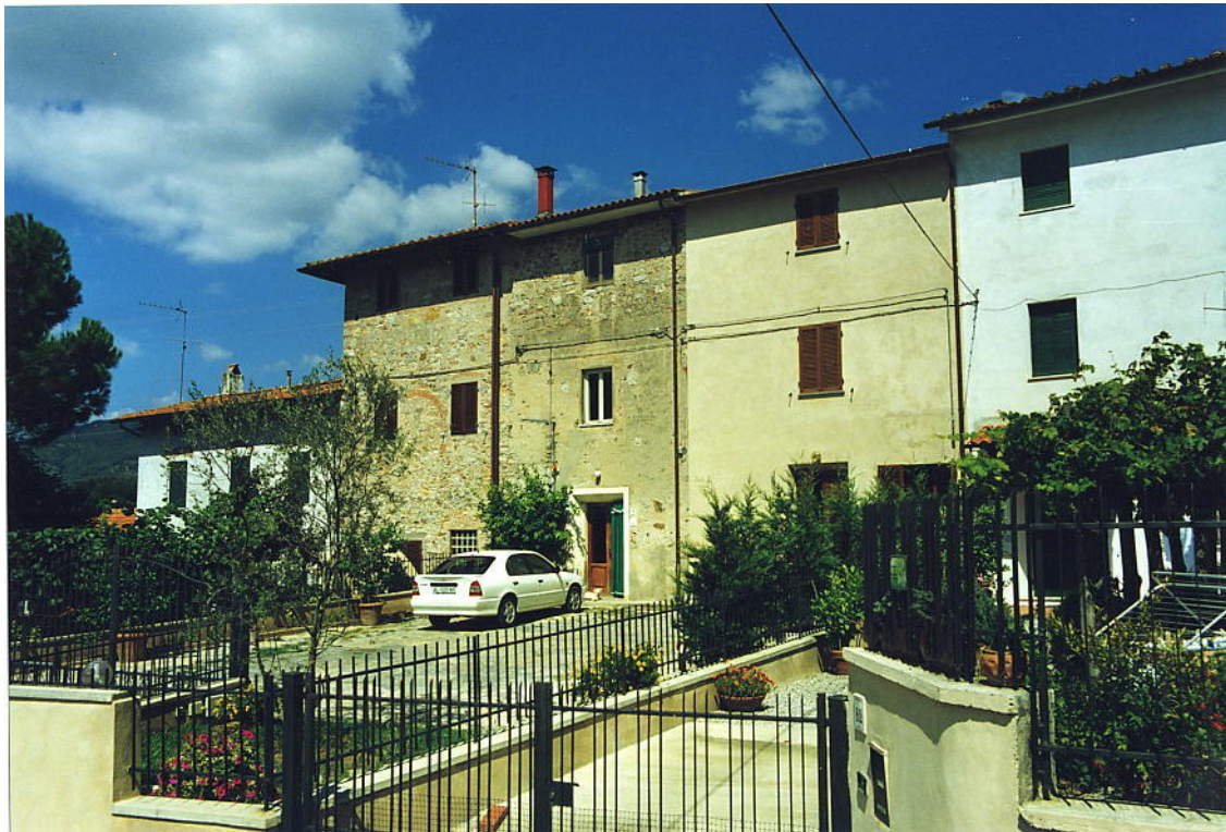
documentazione fotografica al settembre 1999
