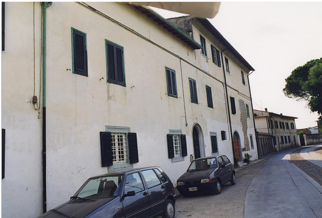
documentazione fotografica al settembre 1999
